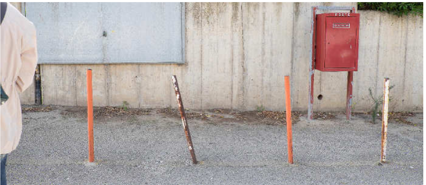
Scheda 23- Fotografia n° 4 INSIDIA STRADALE DEI PALI DI CANTIERE CON EVIDENTE DISALLINEAMENTO
