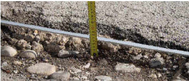
Scheda 2 - Fotografia n° 4 - MISURAZIONE PROFONDITA' DELLA BUCA
