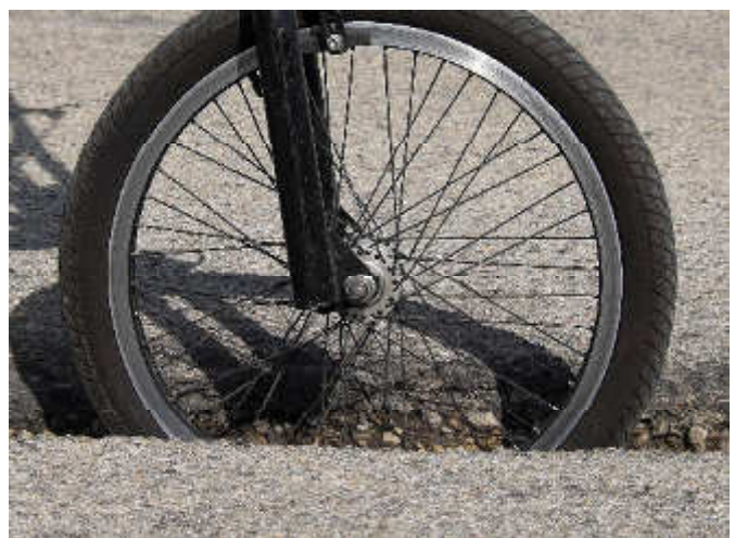
Scheda 3 - Fotografia n° 4 - ESEMPIO SITUAZIONE DI PERICOLO
