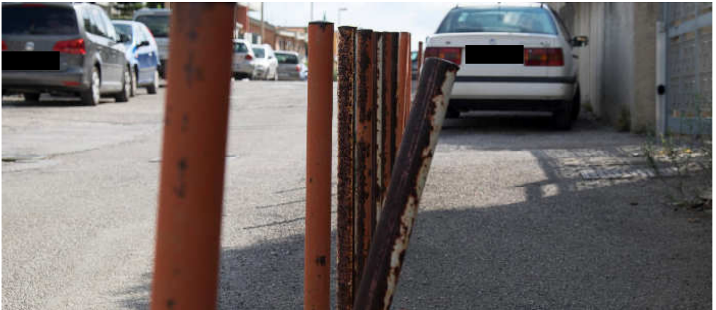
Scheda 23- Fotografia n° 3 INSIDIA STRADALE DEI PALI DI CANTIERE CON EVIDENTE DISALLINEAMENTO
