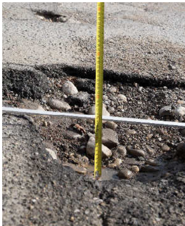
Scheda 4 - Fotografia n° 2 MISURAZIONE PROFONDITA' DELLA BUCA
