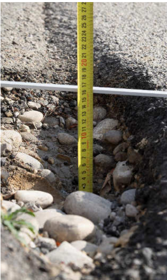
Scheda 3 - Fotografia n° 3 MISURAZIONE PROFONDITA' DELLA BUCA
