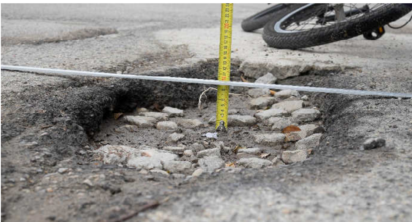
Scheda 19 - Fotografia n° 2 MISURAZIONE PROFONDITA' BUCA
