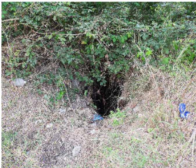
Scheda 26- Fotografia n° 3 TERRENO DISSESTATO
