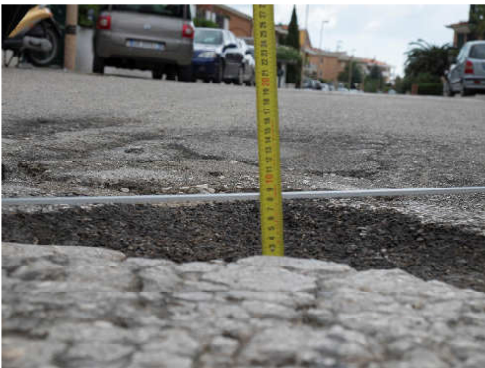
Fotografia n° 4 MISURAZIONE PROFONDITA'
