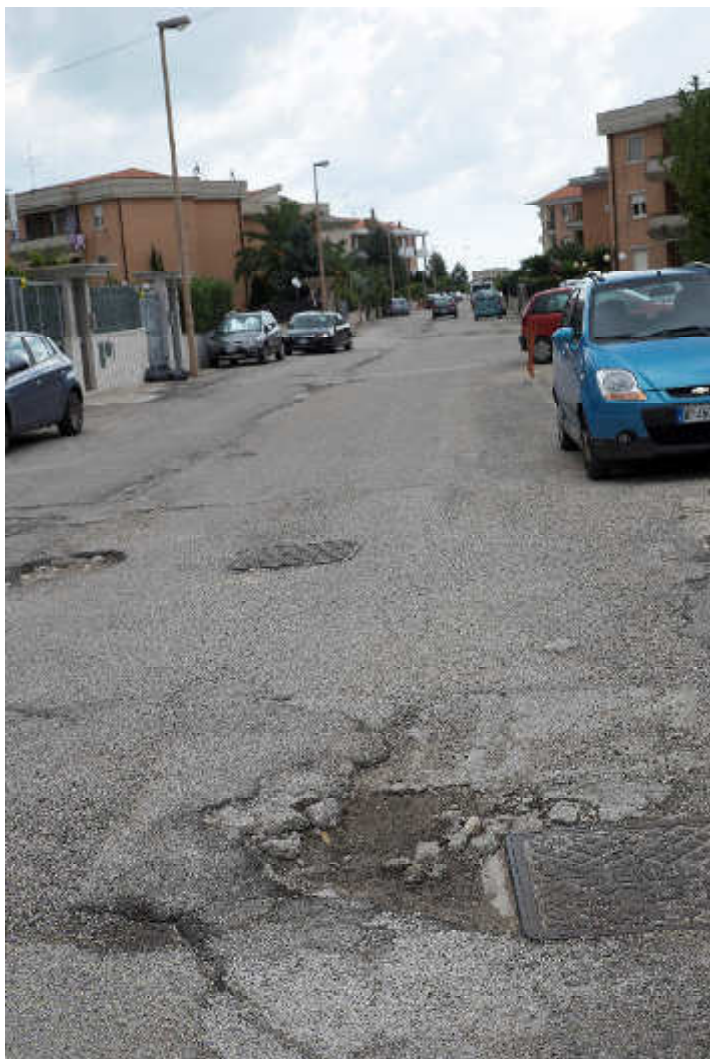
Fotografia n° 1 STATO DELL'ASFALTO
